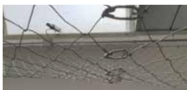
Rete anticaduta PEDONABILE in filo d'acciaio ad alta resistenza, collaudata secondo le normative EN 15057 che permette di realizzare protezioni anticaduta su superfici aperte orizzontali, verticali, inclinate.
