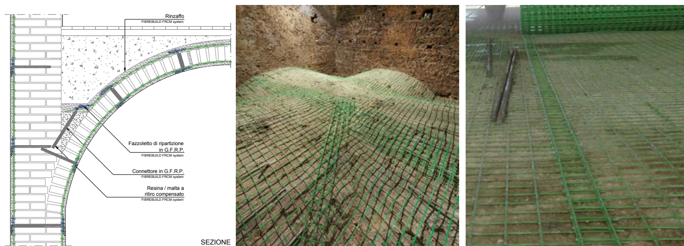
Figura 4. Rinforzo di volte e solai
