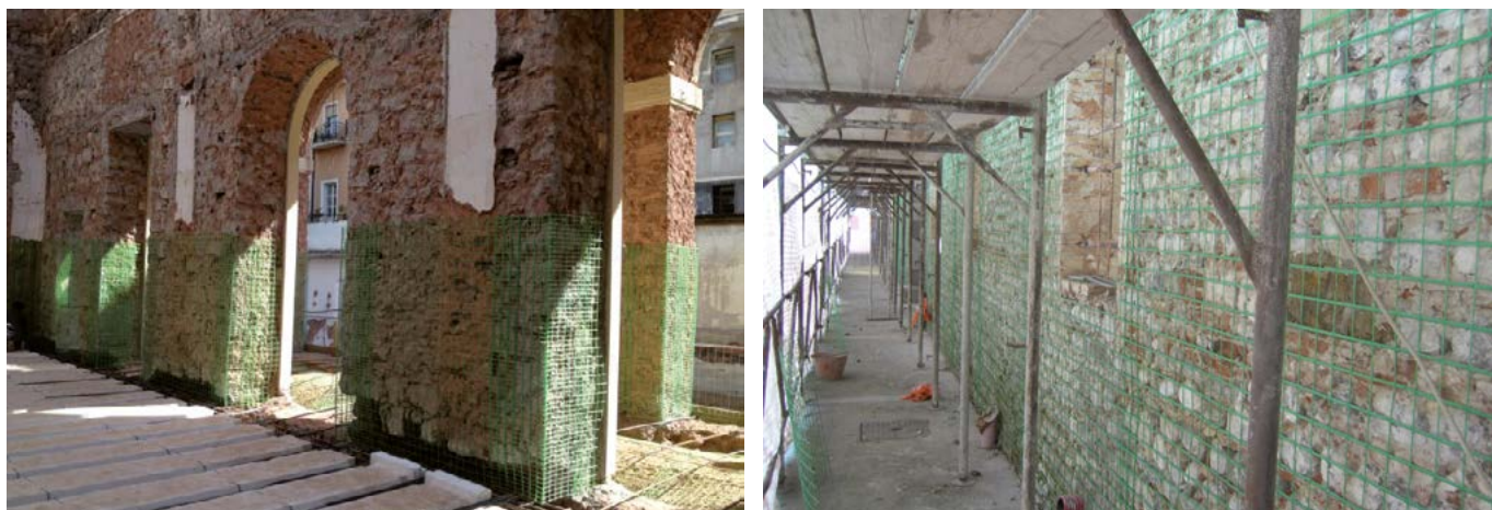
Figura 2. Rinforzo di muratura con il sistema RI-STRUTTURA
