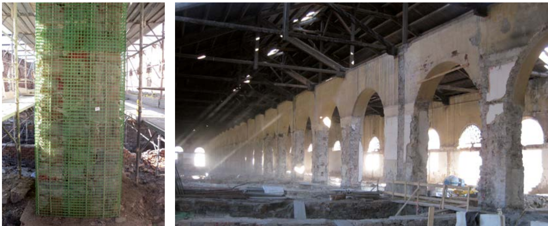
Figura 3. Rinforzo di pilastri in muratura con il sistema RI-STRUTTURA
