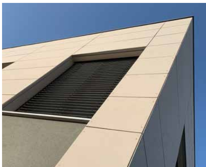
Ufficio commerciale. Facciata realizzata con fibrocemento. Tezze di Piave (TV).
