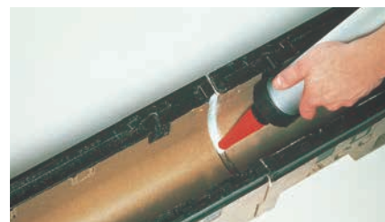
Fase 3 - Sigillatura canale
